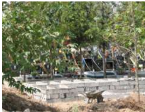
قبرهای انفرادی جدید، در حال احداث بر روی مکانی در گورستان تازه‌آباد که گمان می‌رود محل گور جمعی باشد. عکس از «اخبار روز»
